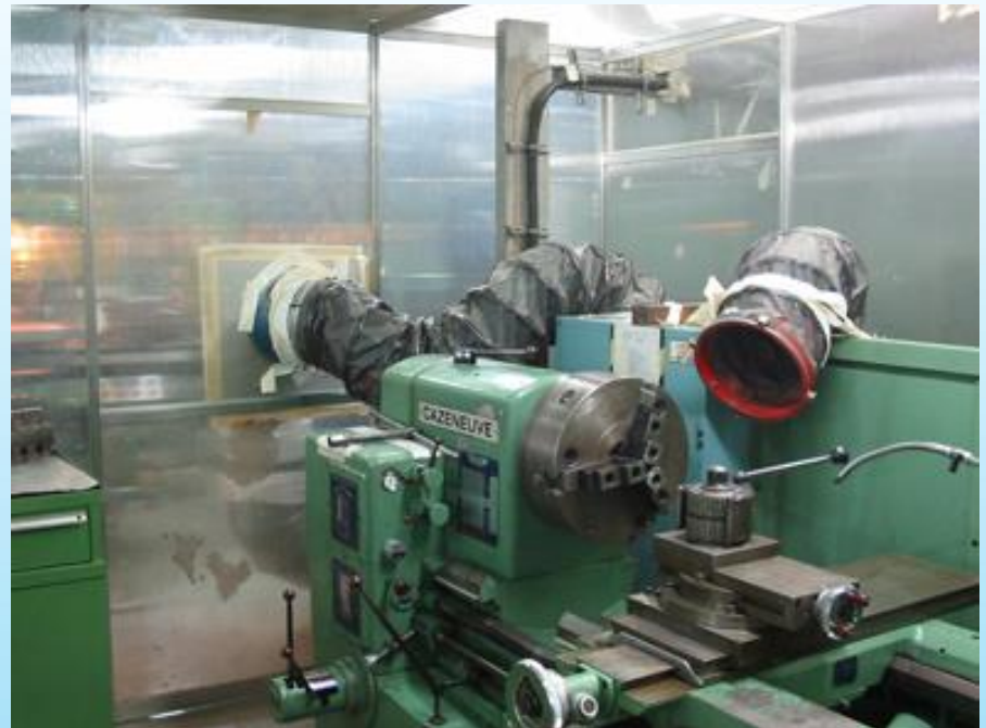
Dans le chantier : aspiration
