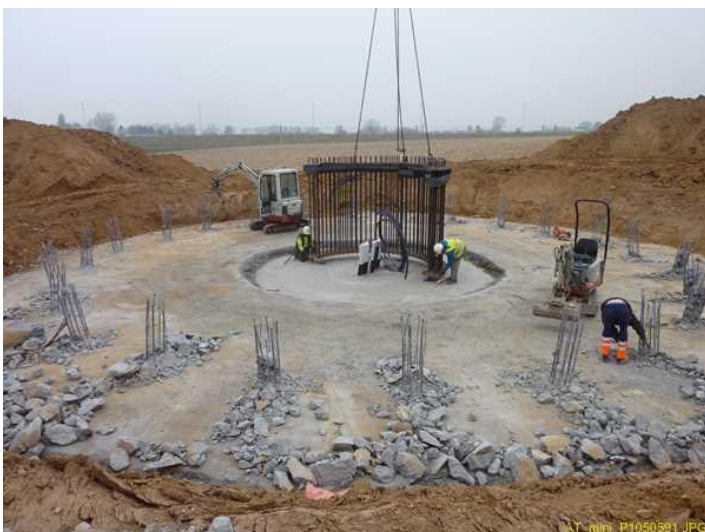
WUUSTWEZEL: plaatsen van de "anchor cage"
