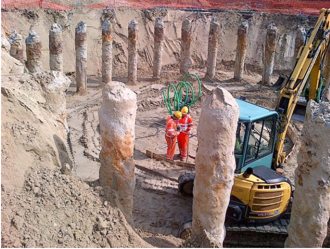
GENK : uitgraven van de werkput; de paalfundering is zichtbaar
