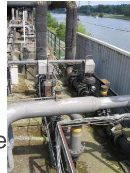
Poste à gaz
